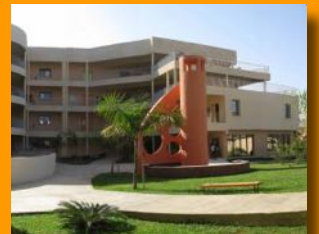
ISD Electricité, climatisation & plomberie
