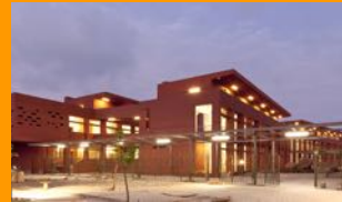
Lycée Jean Mermoz - Dakar Climatisation, électricité courant fort et courant faible, groupe électrogène, éclairage extérieur avec des lampadaires solaires
